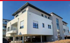
Senioren-WG Bersenbrück Schulstraße 4 49593 Bersenbrück
