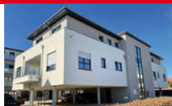
Senioren-WG Bersenbrück Schulstraße 4 49593 Bersenbrück
